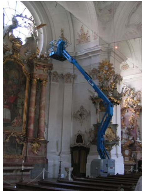
Abb. 9a - 9c: Objektpunkte (Prismen werden lackiert und mittels Hubsteigers eingebaut)
