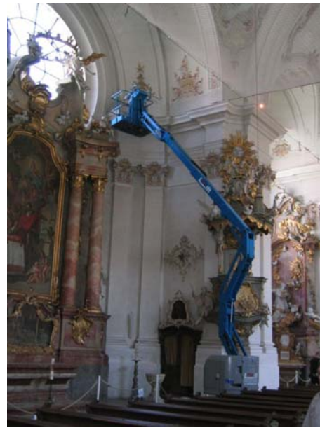
Abb. 13a - 13c: Objektpunkte (Prismen werden lackiert und mittels Hubsteigers eingebaut)
