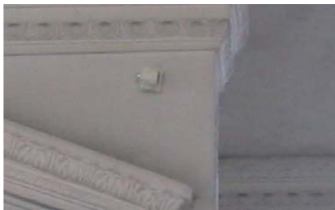
Abb. 13a - 13c: Objektpunkte (Prismen werden lackiert und mittels Hubsteigers eingebaut)
