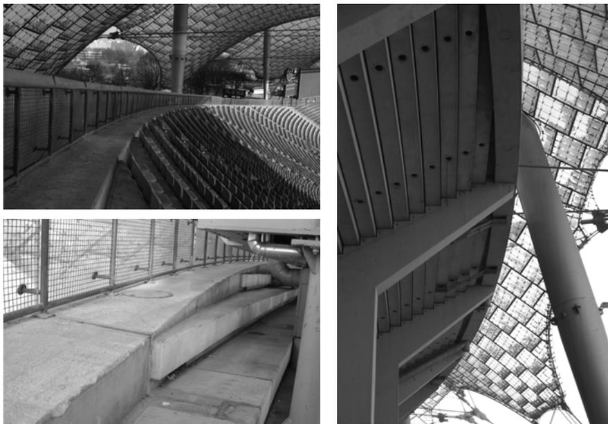
**Abb. 5:** Ober- und Unterseite der Hohlkastenkonstruktion an der Haupttribüne (oben links und rechts) sowie anbetonierte „Stummelstufen“ (unten links)
